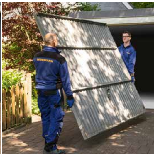
Ausbau und umweltgerechte Entsorgung
